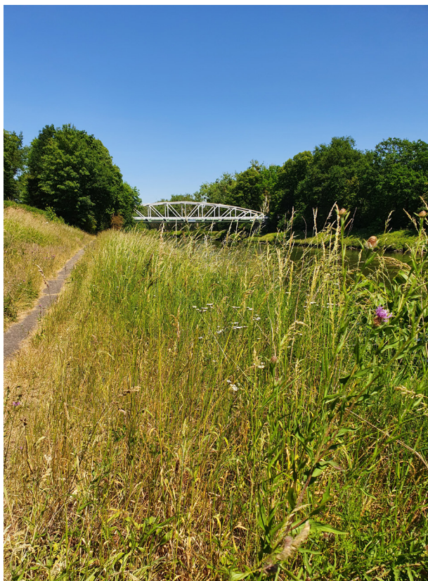
Fig. 3. Binnenkant van de westelijke dijk van het Julianakanaal ter hoogte van Geulle. Foto Gerard Majoor.
